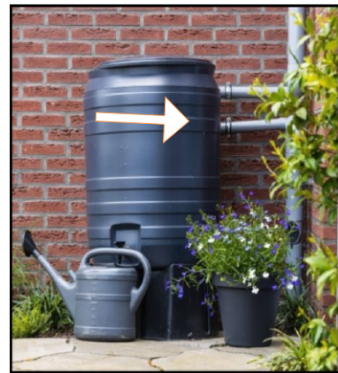
Wat kan er beter aan deze regenton ? (Als het water tot de pijp komt, gaat het alsnog het riool in. Niet doen: gewoon laten overlopen. Goed voor het grondwaterpeil)
